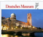
Sammlungsbau des Deutschen Museums in München. Im Vordergrund die Boshäbrücke über die Isar.
